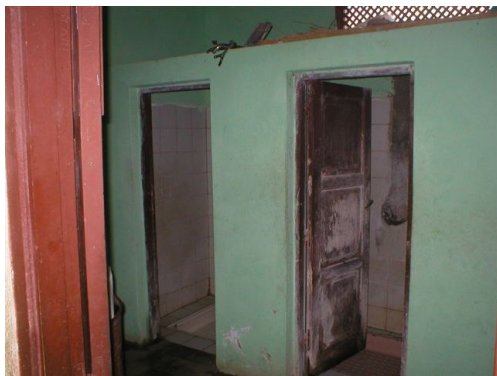
Sanitair vóór de verbouwing
